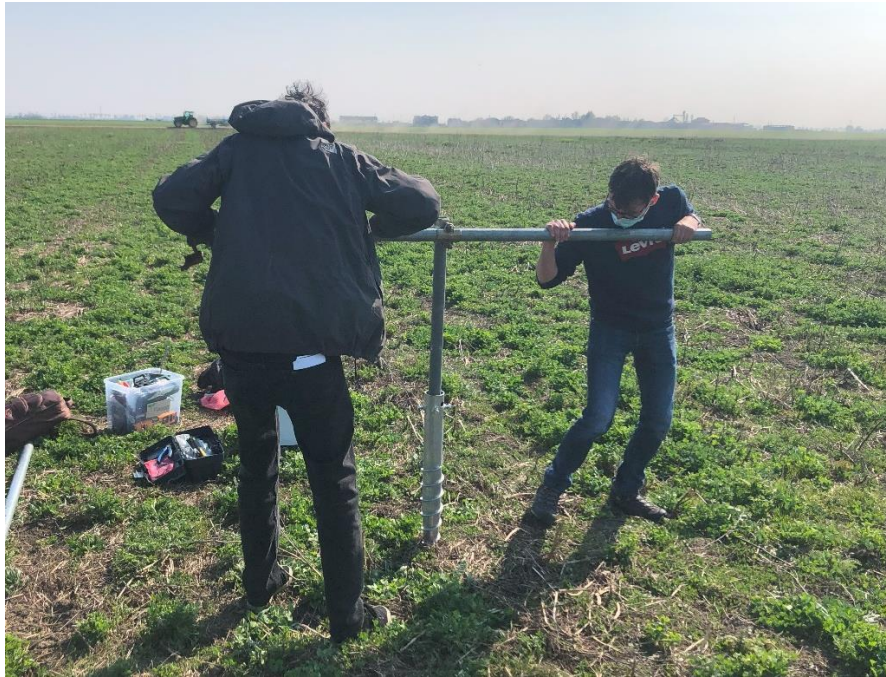
Figura 12: Installazione dalla base a vite
